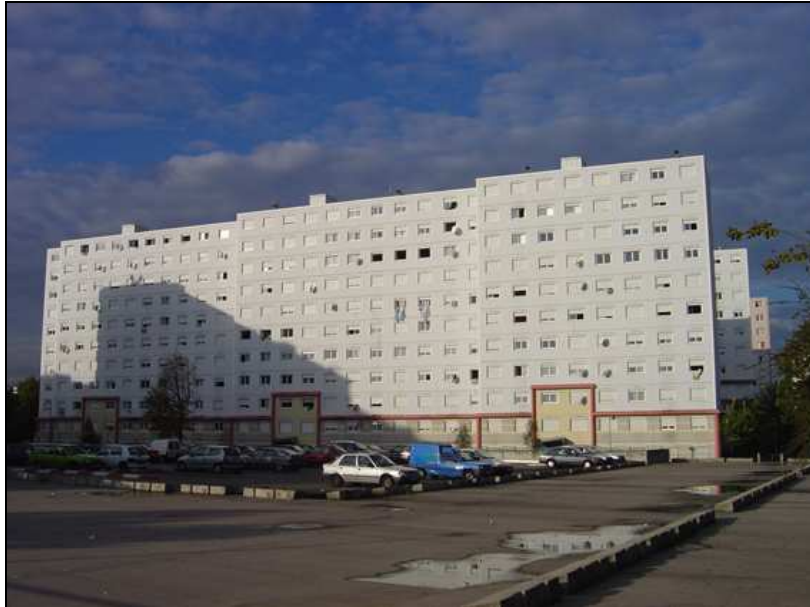
Figure 3 : Façade du 15 au 19 Chemin avant la réhabilitation
